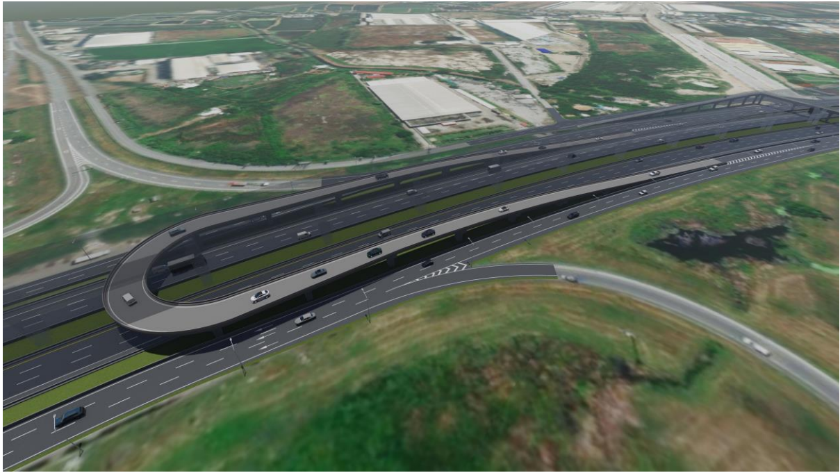
รูปที่ 5.3-2 รูปแบบสะพานกลับรถเกือกม้า (U-Turn) ของโครงการ
